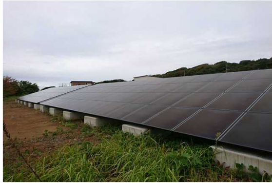
太陽光パネル
