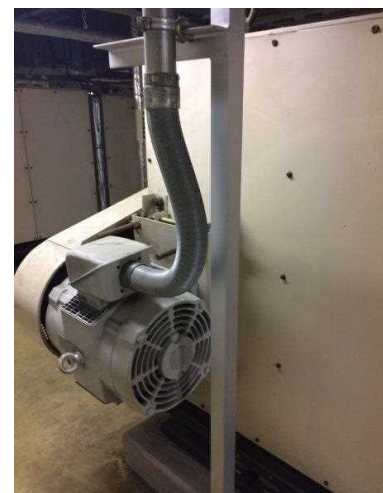
給気ファン(ダクト)
