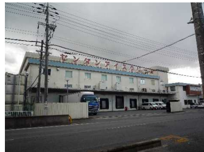
工場全景。 工業団地内に立地している。
