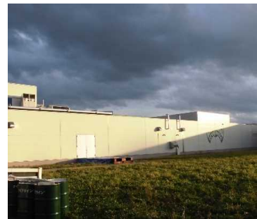
工場全景。 工業団地内に立地している。
