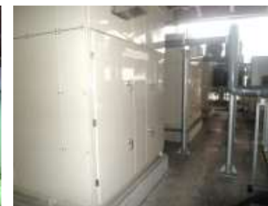
冷凍機 : 庇がある屋外に設置。
