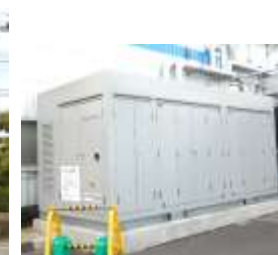
冷凍機 : 屋外地上に設置。
