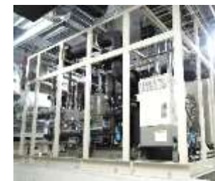
冷凍機 (NH 3 /CO 2 ) : 機械室内の設置。
