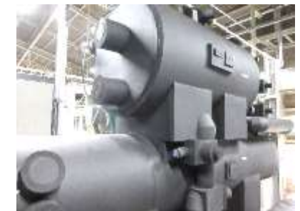
冷凍機 : 機械室内の設置。
