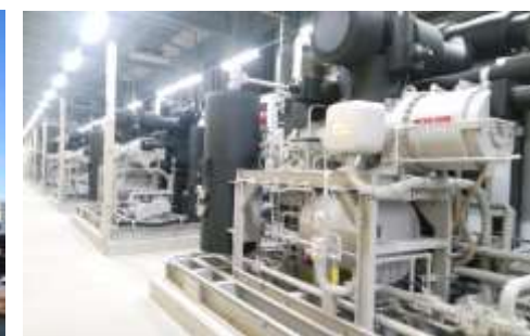
冷凍機：屋内機械室に冷凍機を設置
