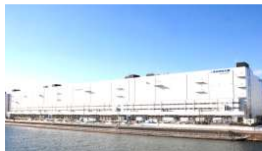
全景：日本最大規模の倉庫
