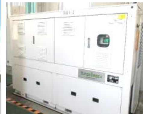
冷凍機 : 屋内機械室に設置
