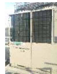
冷凍機 (CO 2 ) : 屋上に設置。
