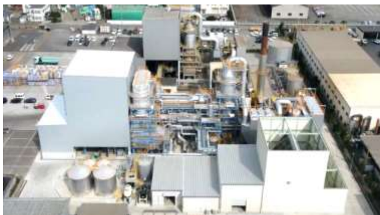
(5号炉 (廃棄物焼却・熱回収設備・発電設備) の新設)
