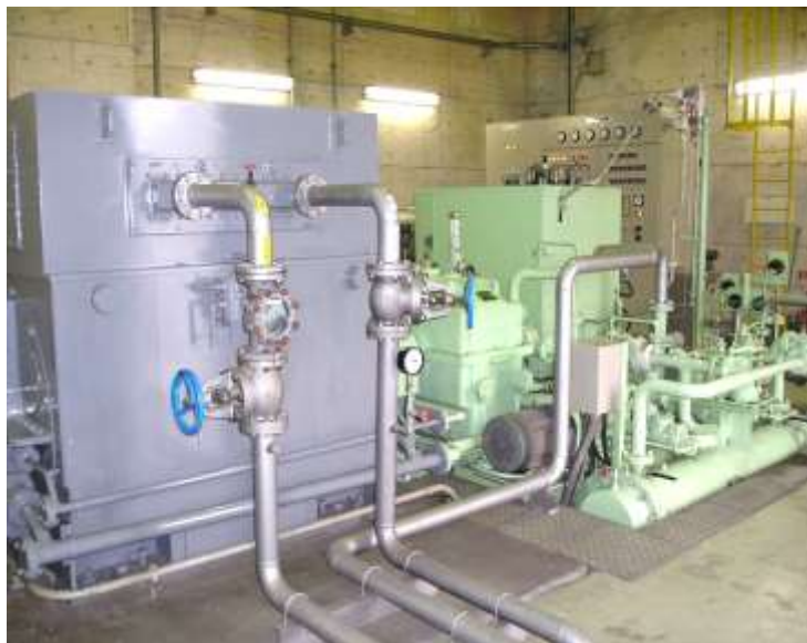
蒸気タービン発電機（背圧式）
