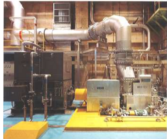
蒸気タービン発電機（復水式） （出所：茅ヶ崎市環境事業センターパンフレット）
