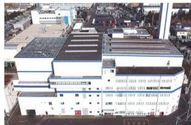
環境事業センター外観
