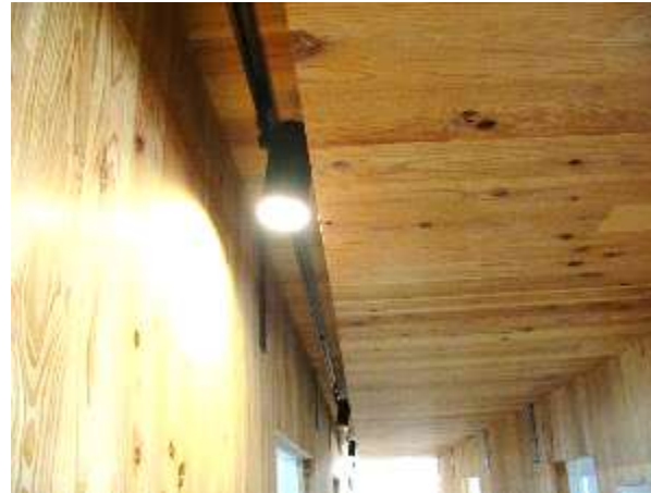
多灯分散照明方式を採用
