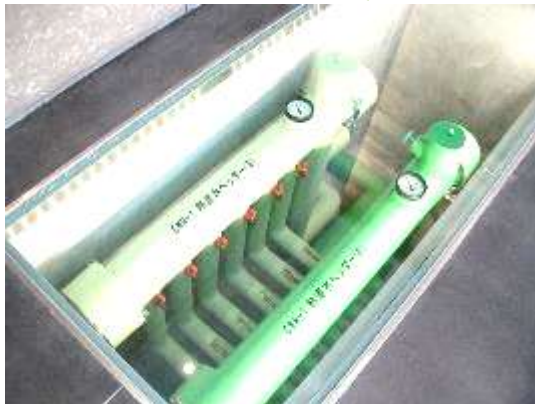
床下の地中熱システム
