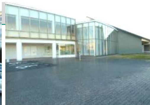
建物の外観（図書館）
