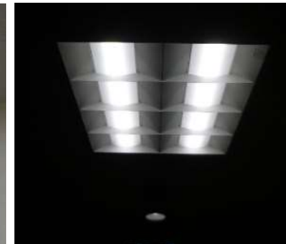
LED照明②※調光したLED照明
