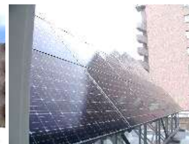
太陽光発電システム
