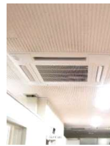
空調設備（室内機）とLED照明
