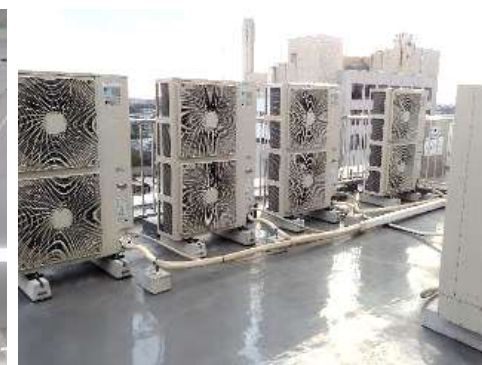
空調設備（室外機）
