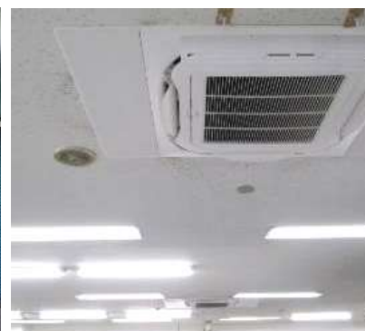
空調設備（室内機）とLED照明
