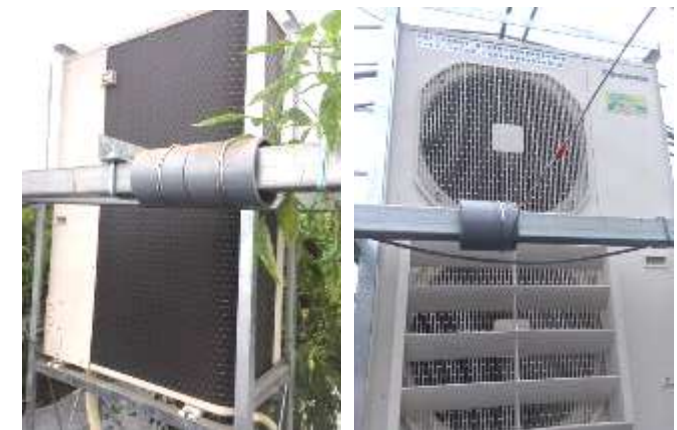
空調設備室内機
