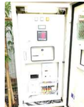
融雪設備(内部)
