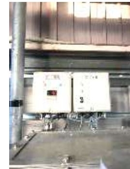
温度計・給水装置スイッチ
