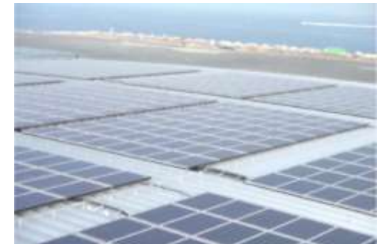
太陽光発電パネル 折板屋根への設置
