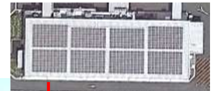
太陽光パネル (屋根上)
