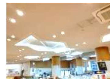
照明更新による美観向上（温泉施設）
