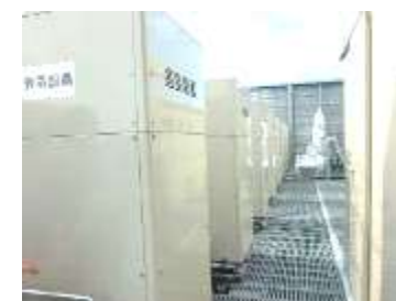
屋上に設置されたコジェネ8台
