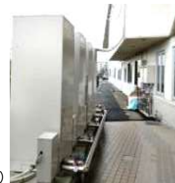
細長い空きスペースに置かれた貯湯タンク（460L/基）
