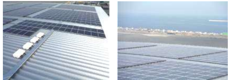
太陽光発電パネル (工場屋上)
