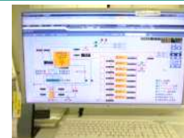
中央監視室の監視画面
