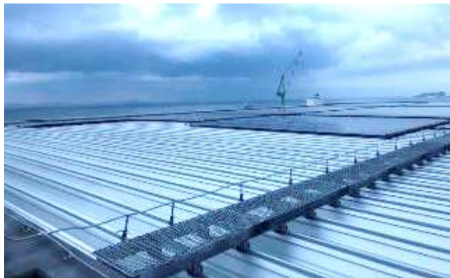
メンテナンス用足場
