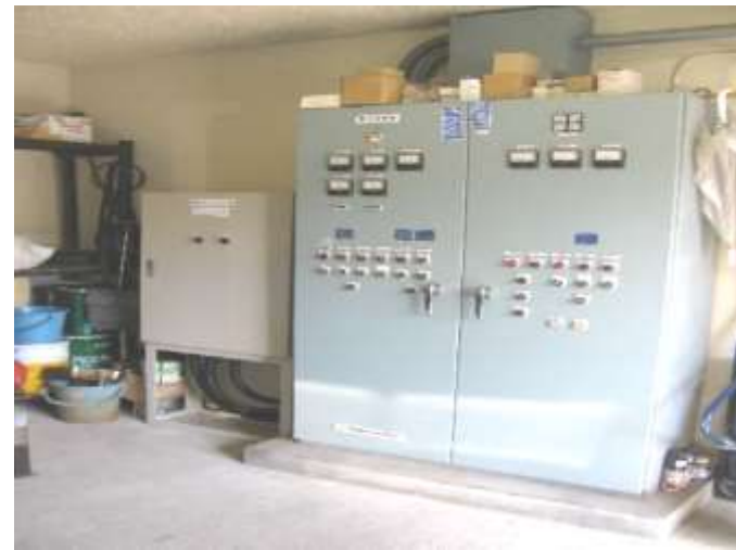
配電盤とインバータボックス
