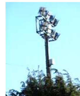
グラウンドの照明（中学校）
