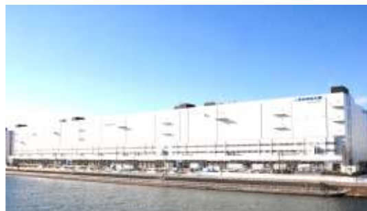
全景：日本最大規模の倉庫
