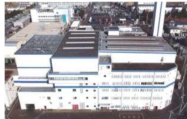
環境事業センター外観
