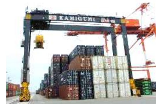
ハイブリッド型トランスファークレーン全景
