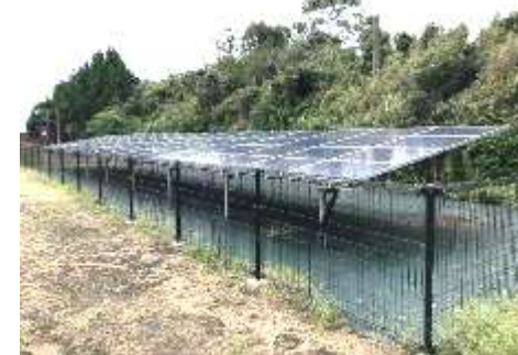
太陽光パネル (2)
