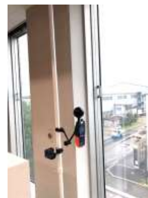
空調システム（温度センサー）
