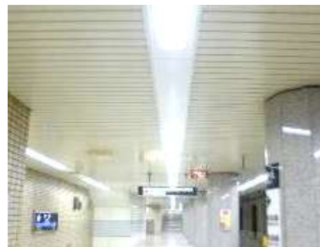
調光していないホームのLED照明
