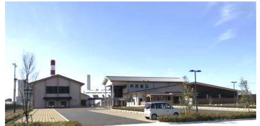
余熱利用施設
