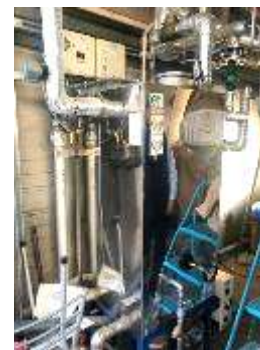
排熱(水)回収設備
