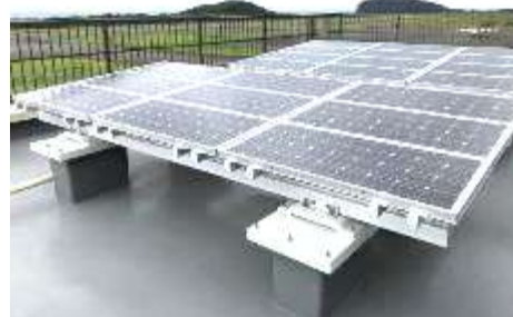
太陽光パネル (1)
