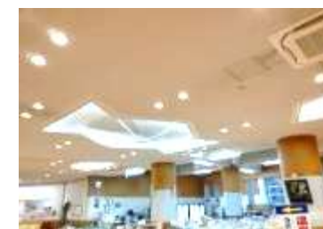
照明更新による美観向上（温泉施設）
