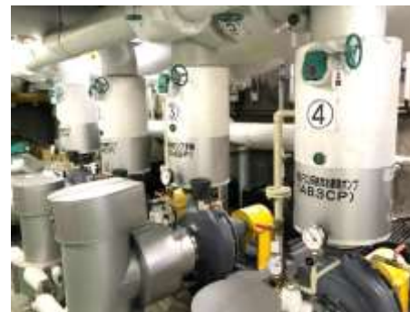
冷水・冷却水ポンプ
