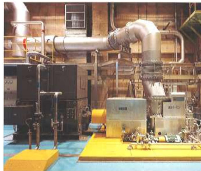
蒸気タービン発電機（復水式） （出所：茅ヶ崎市環境事業センターパンフレット）
