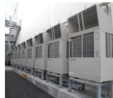
冷凍機 : 架台の上に乗せて通気性を向上させている。
