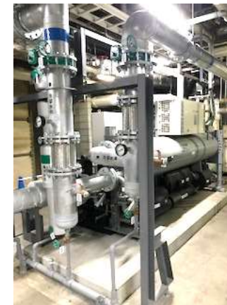
ターボ冷凍機
