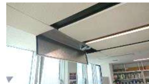
空調システム（空調ダクトパネル）
