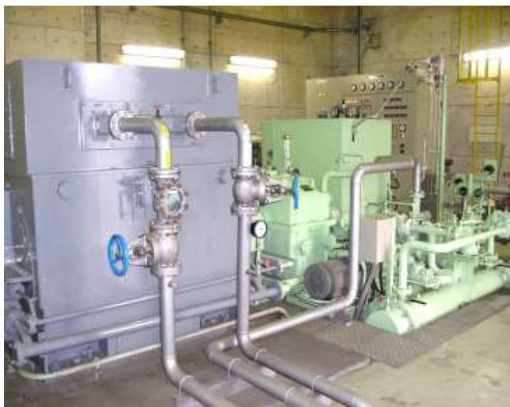
蒸気タービン発電機（背圧式）
