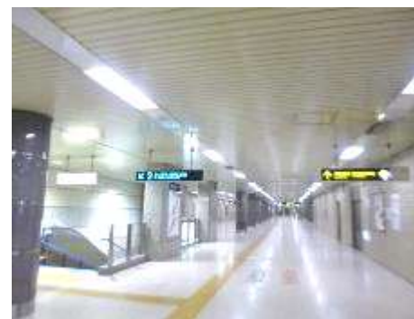
明るさを20%低減したコンコースのLED照明
