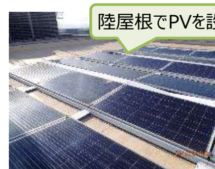
陸屋根上 太陽発電パネル
