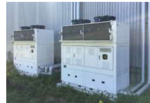
冷凍機 : 屋外地上に設置。
