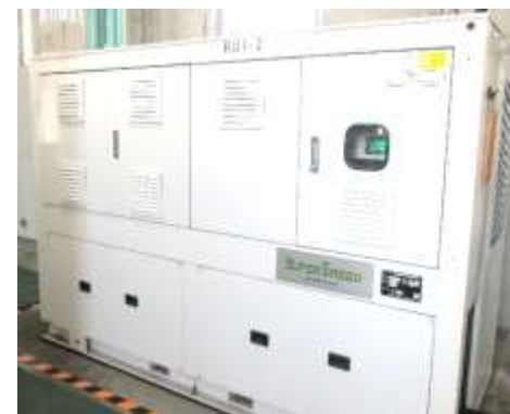
冷凍機 : 屋内機械室に設置
