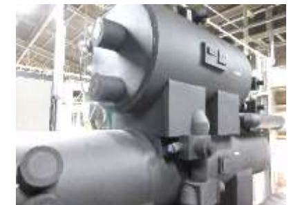
冷凍機 : 機械室内の設置。
