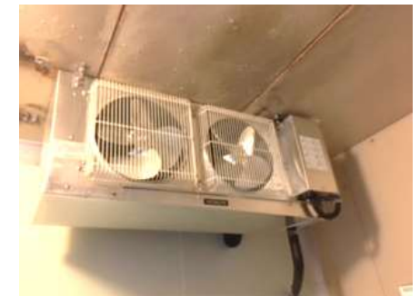
バックヤード冷凍冷蔵庫
