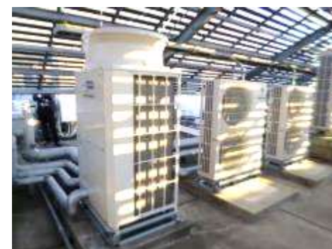
高効率空調（室外機）
