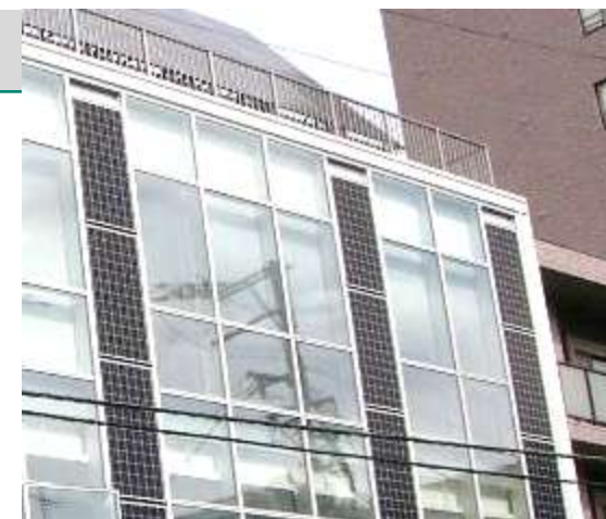
外壁にも太陽光パネルを設置
