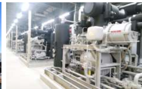
冷凍機：屋内機械室に冷凍機を設置
