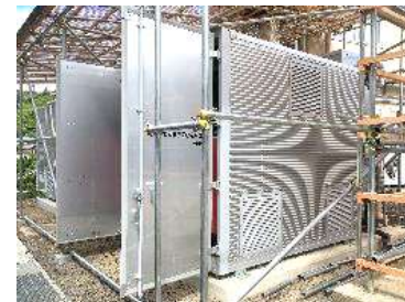
潜熱回収温水ヒーター（室外機）
