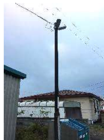
LED照明（白老町）
