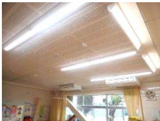
空調設備とLED照明（小学校）
