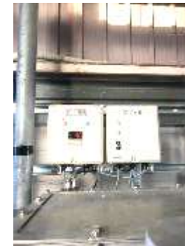
温度計・給水装置スイッチ
