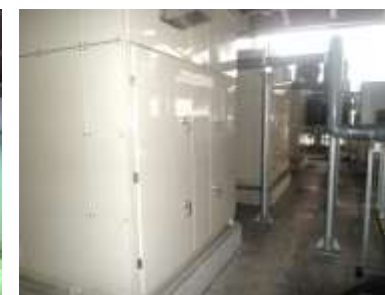
冷凍機 : 庇がある屋外に設置。
