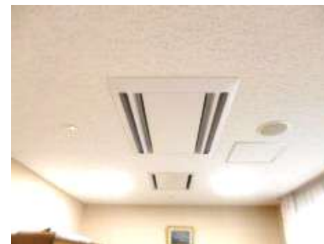
高効率空調（室内機）とLED照明
