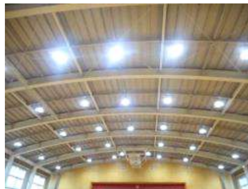
体育館のLED照明（小学校）
