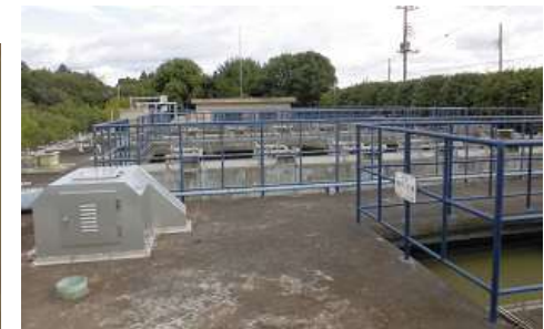
6000人槽浄化槽外観
