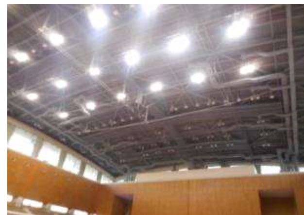
調光機能を導入したLED照明（スポーツセンター）
