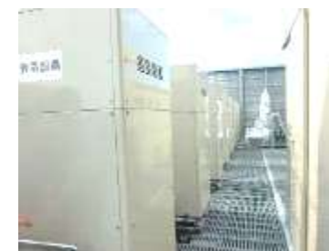
屋上に設置されたコジェネ8台
