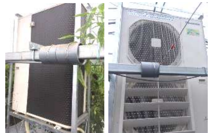
空調設備室内機
