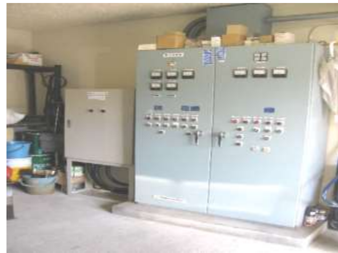
配電盤とインバータボックス
