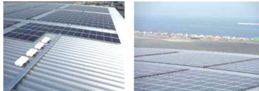
太陽光発電パネル (工場屋上)
