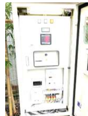
融雪設備(内部)
