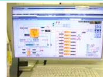
中央監視室の監視画面
