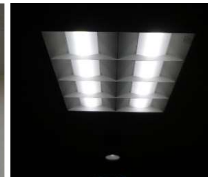
LED照明②※調光したLED照明
