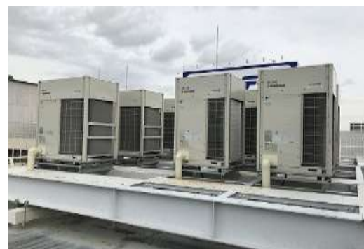
空冷ヒートポンプエアコン （室外機）
