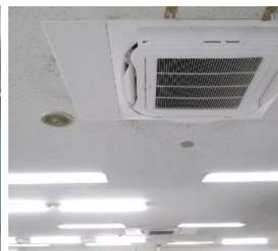
空調設備（室内機）とLED照明
