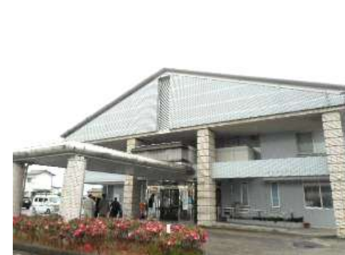
建物の外観（保健福祉センター）
