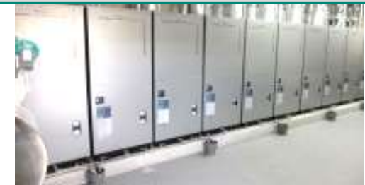
ヒートポンプ8台 (融雪用HPも合わせて設置)
