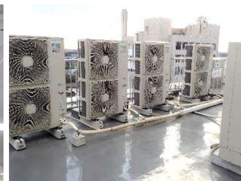
空調設備（室外機）
