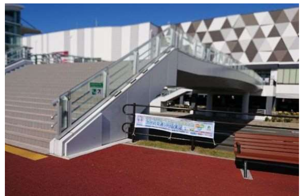
図 25 商業施設入口への設置
