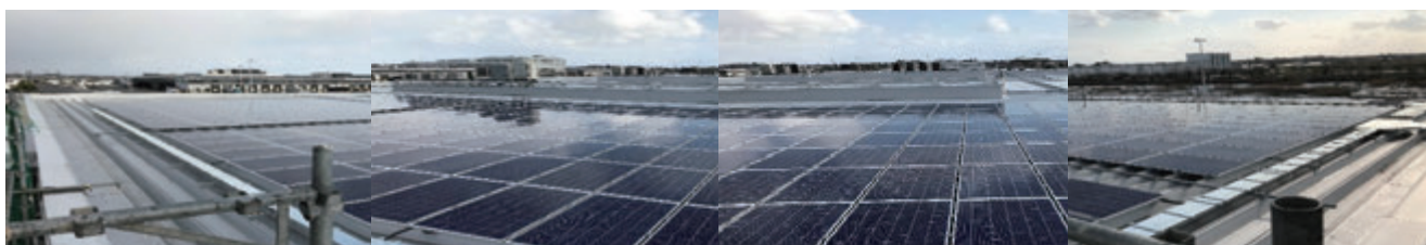
太陽光パネル
