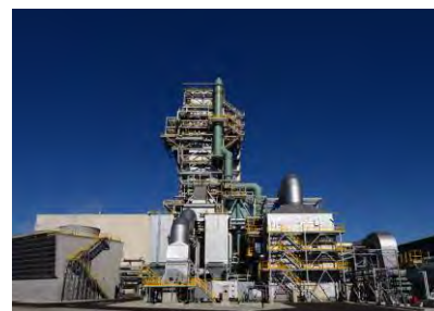
バイオマス発電施設
