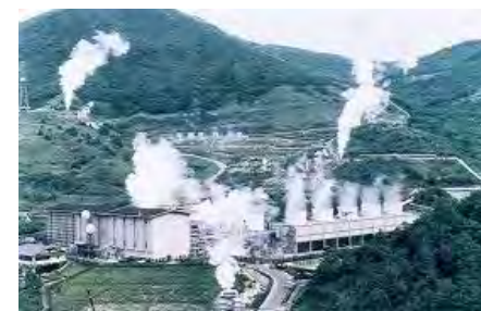
大分県HP引用 地熱発電施設
