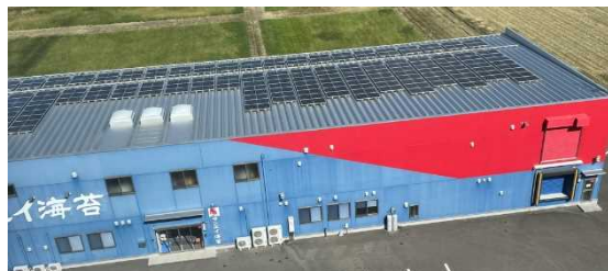
太陽光発電設備①
