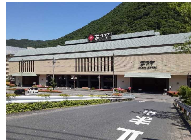
対象施設の外観（あさやホテル）
