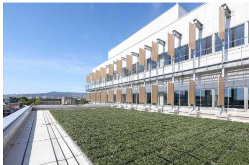
雨水利用灌水の屋上緑化
