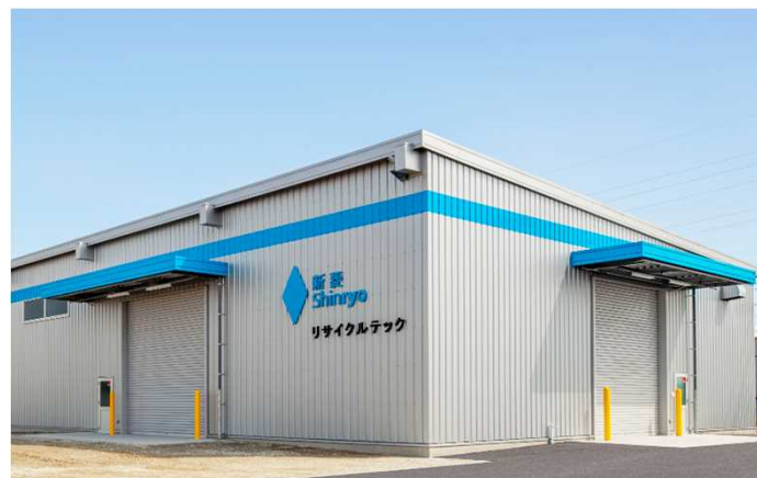
対象施設の外観
