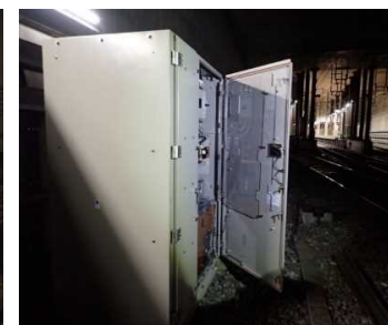
駅舎補助電源装置 (左：遠景、右：近景)
