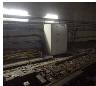
駅舎補助電源装置 (左：遠景、右：近景)
