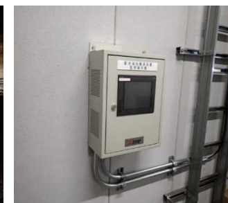
駅舎補助電源装置の 監視制御装置
