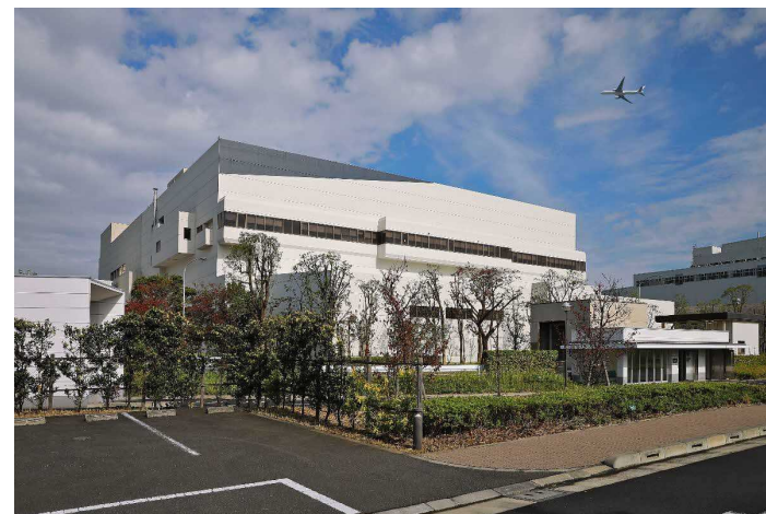
対象施設の外観（大田清掃工場第一工場）
