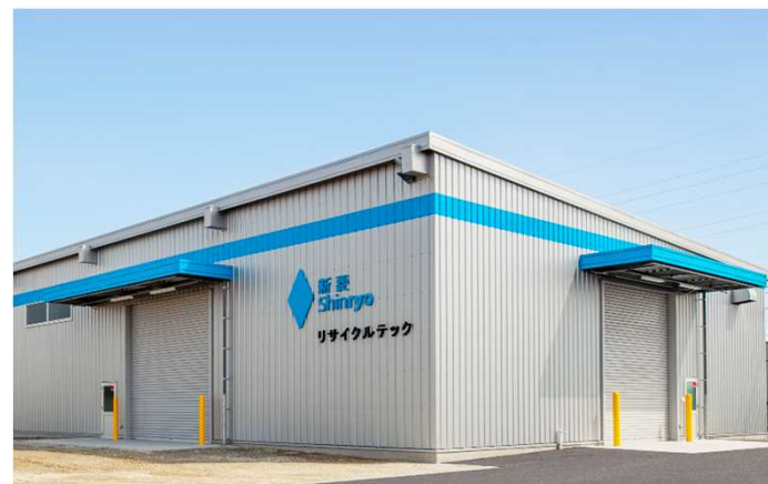
対象施設の外観
