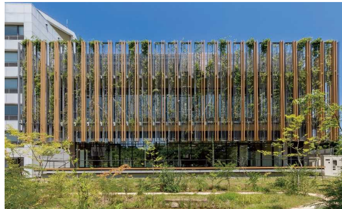
対象施設（戸田建設筑波技術研究所 グリーンオフィス棟）の外観
