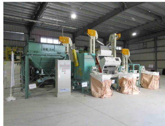
導入設備の全景
