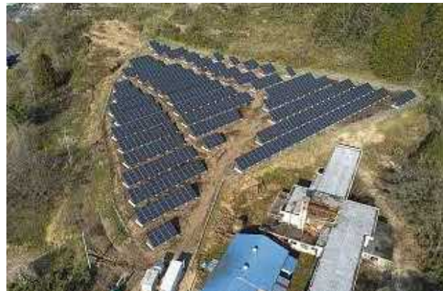
太陽光発電と蓄電池
