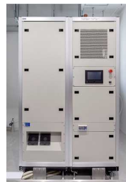
水素燃料電池
