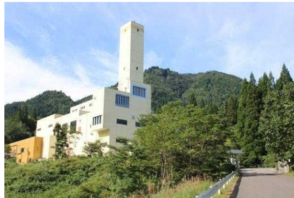
対象施設の外観（大館クリーンセンター）
