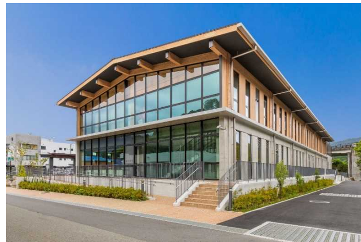
2階木造部分の外壁にCLT耐震パネルを採用
