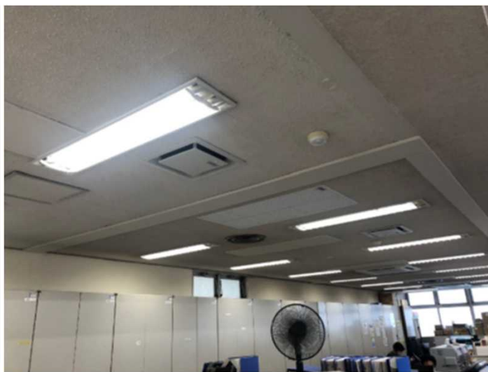
高機能換気設備（全熱交換器）
