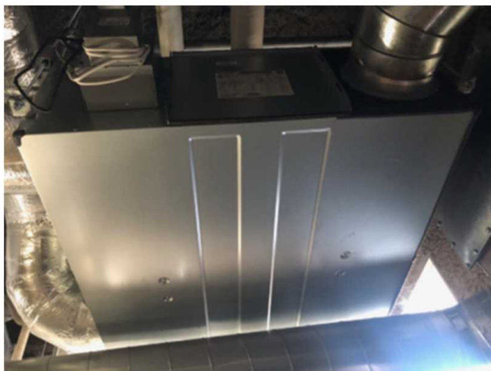
高機能換気設備（全熱交換器）
