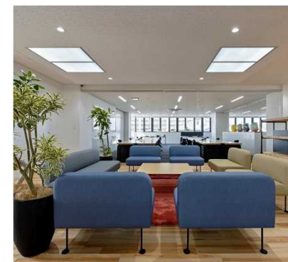
光ダクトで天井から自然光※
