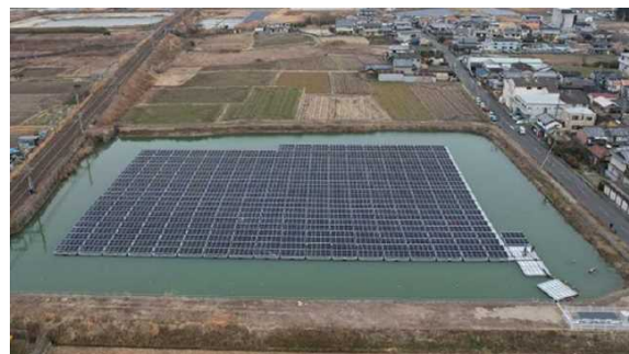
太陽光パネル (フオート式架台に設置)
