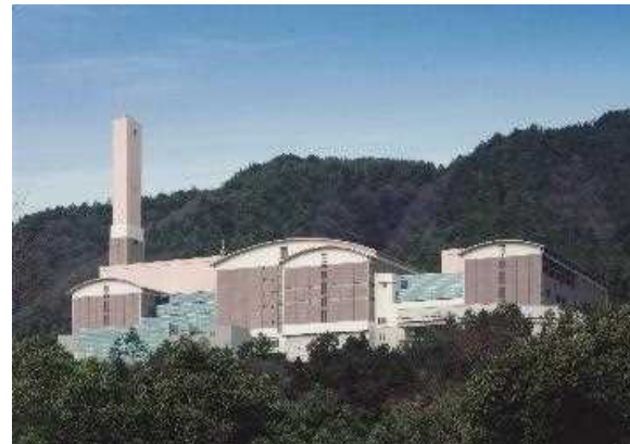
対象施設の外観(京都市東北部クリーンセンター)
