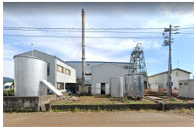
導入前 重油タンク
