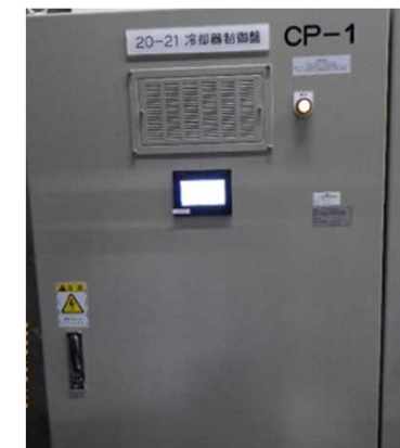
制御盤（補機）
