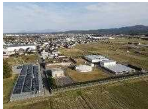
竹矢ポンプ場
