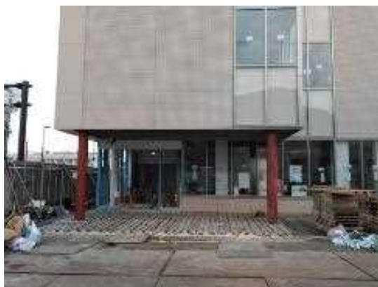
施行中のヒートパイプの様子
