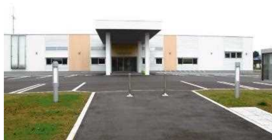
対象施設（中札内村役場庁舎）の外観
