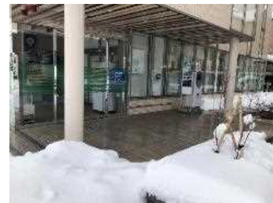
降雪時のヒートパイプによる 融雪の様子
