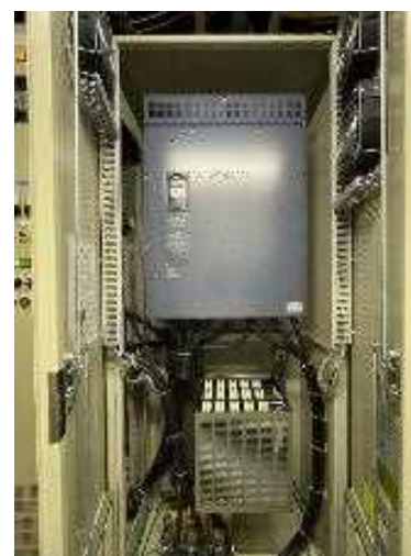
インバータ制御装置 (冷温水ポンプ用)
