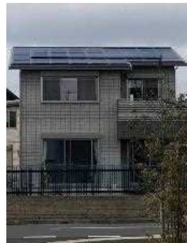
PV集熱パネル
