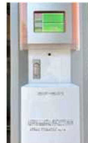
ガス焼き高効率ボイラ (制御装置)
