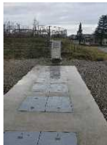
浄化槽システム
