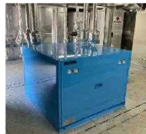
海水淡水化熱源給湯ヒートポンプ
