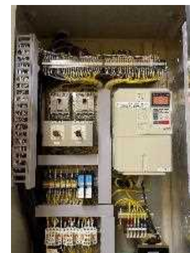
インバータ制御装置 (空調設備用)
