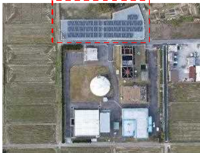
写真：竹矢ポンプ場（真上）
