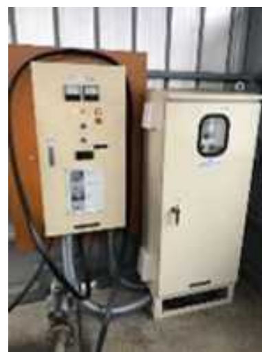
インバータ制御装置 (設備本体)
