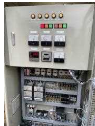
インバータ制御装置 (設備本体)
