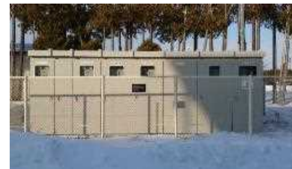
主高圧受電盤
