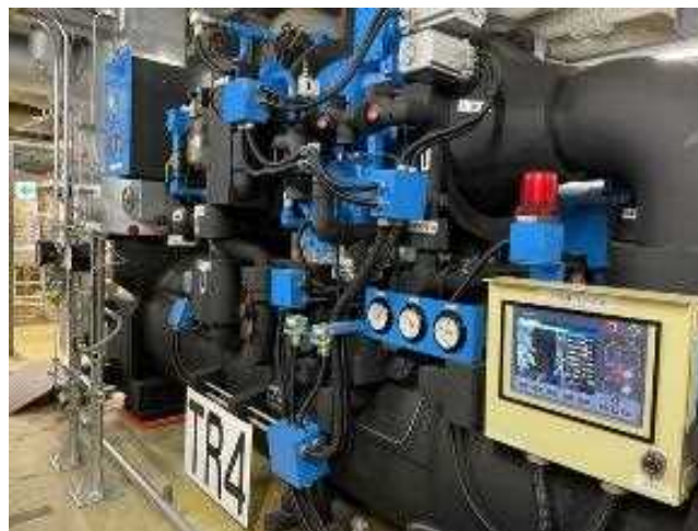
インバータターボ冷凍機
