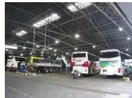
LED照明 (全体)
