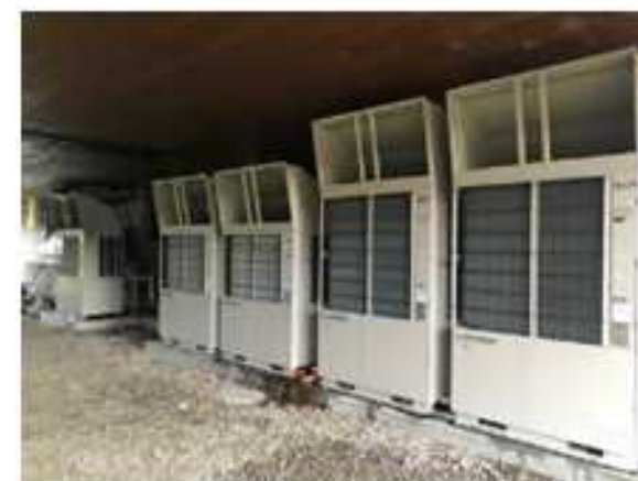
ヒートポンプ給湯器・ 高温水ヒートポンプ
