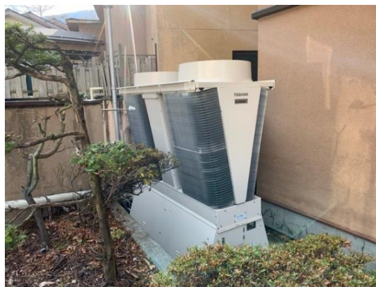
循環加温ヒートポンプ
