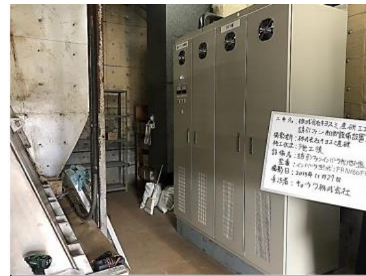
誘引ファンインバータ制御盤
