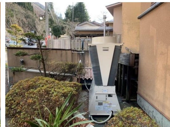
循環加温ヒートポンプ
