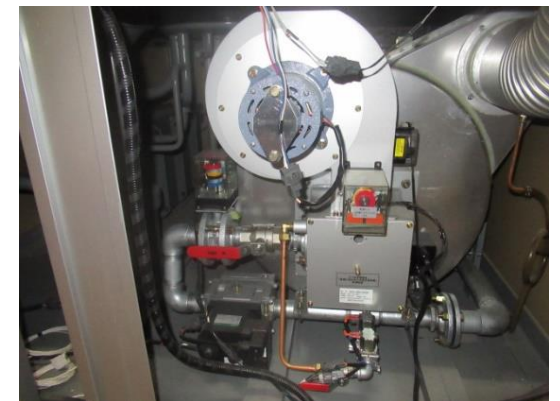
ガスバーナー配管
