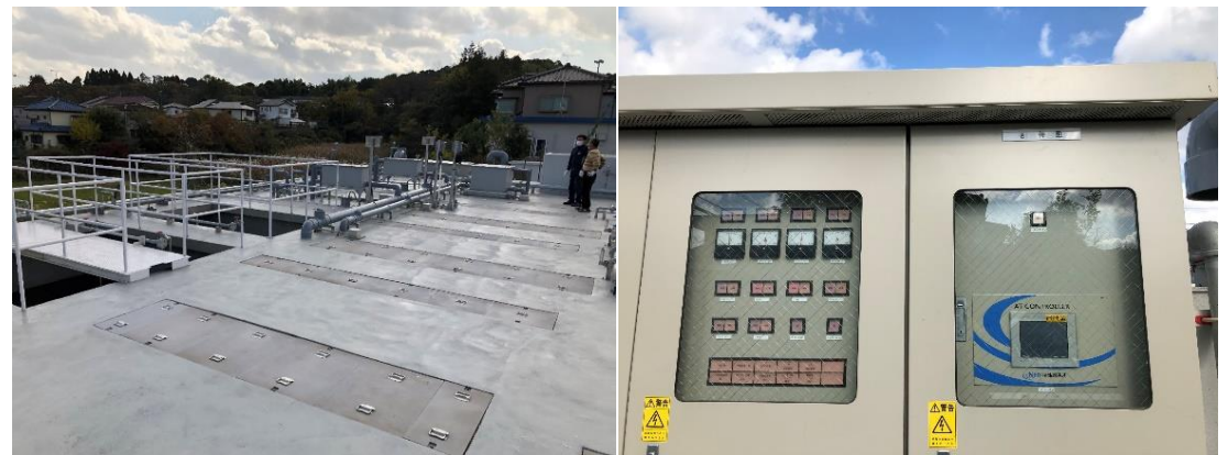
浄化槽システム (全体)
