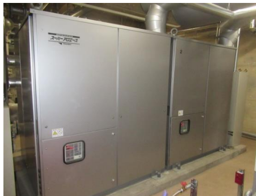
冷温水発生器
