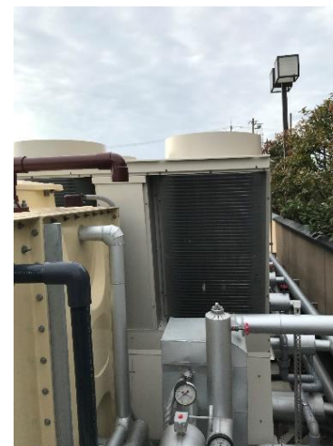
ヒートポンプ熱源設備
