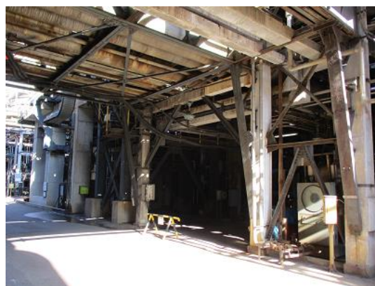
LED照明 (全体)
