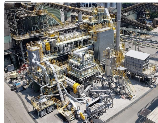
低温加熱脆化プロセス (導入設備全景)
