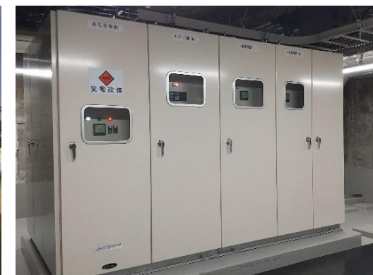
補助対象設備 (受変電設備)
