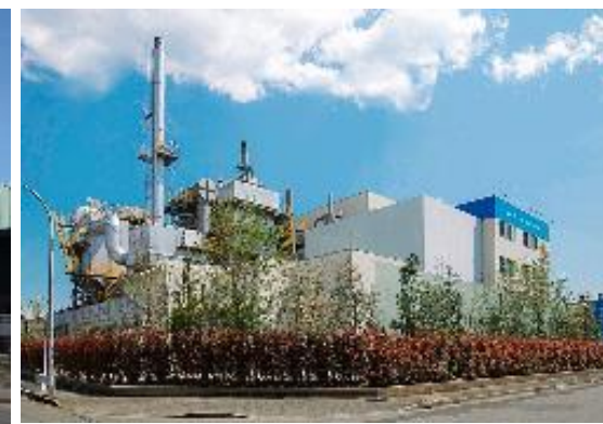
焼却熱回収発電システム (設備本体)
