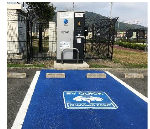
EV急速充電器
