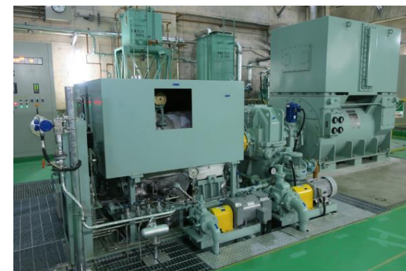
蒸気タービン発電機
