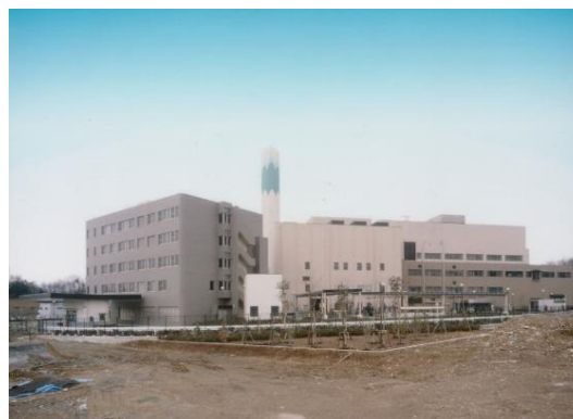
戸吹清掃工場
