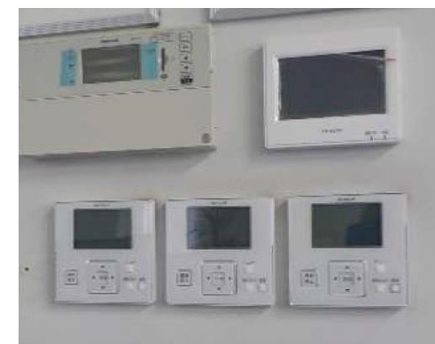
空調設備 (制御盤)
