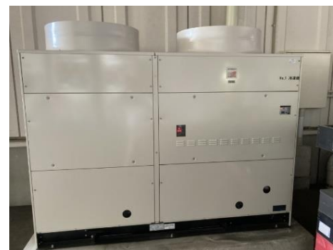
冷凍設備（室外機）
