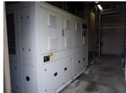
冷凍機ユニット
