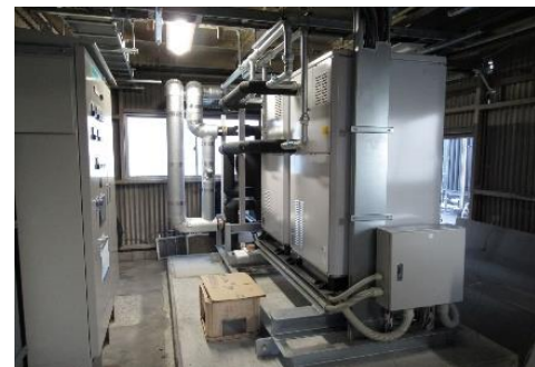
冷凍機ユニット
