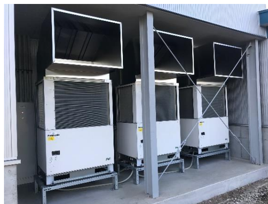
冷凍機ユニット
