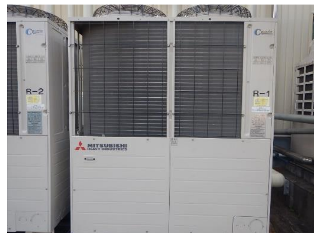
冷凍機ユニット
