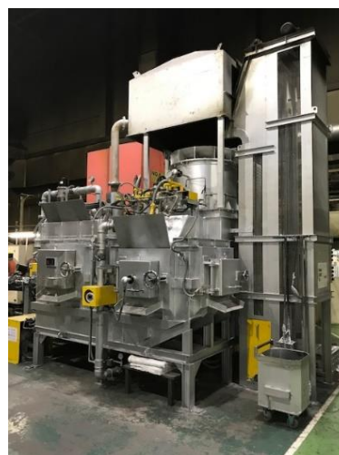
高効率燃焼式工業炉 (設備本体)
