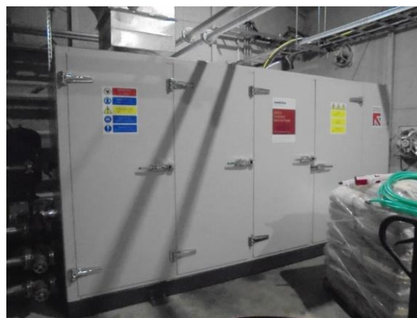
バイオガス発電機
