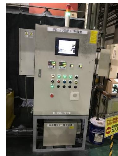
高効率燃焼式工業炉 (制御盤)
