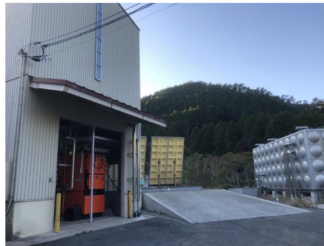
エネルギーセンター (バイオマスボイラー導入場所)
