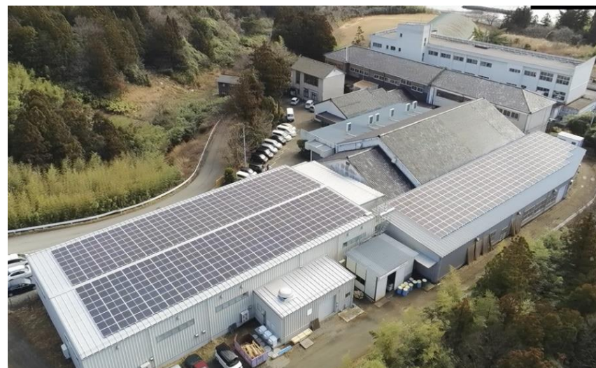
対象施設 (佐渡精密(株)本社工場) の外観
