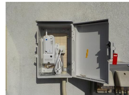
外気温測定を行い、BEMSと連動（ナイトパーズ実施）
