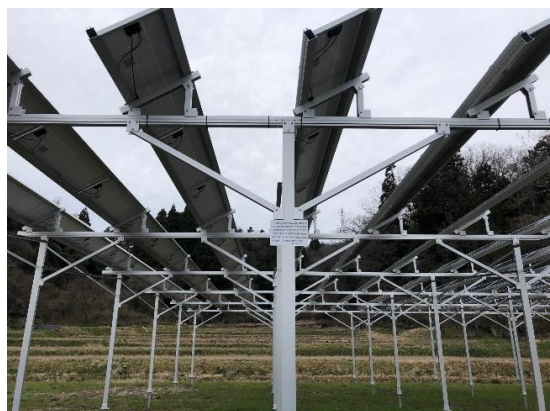
太陽光パネル（遮光率30%）の設置状況
