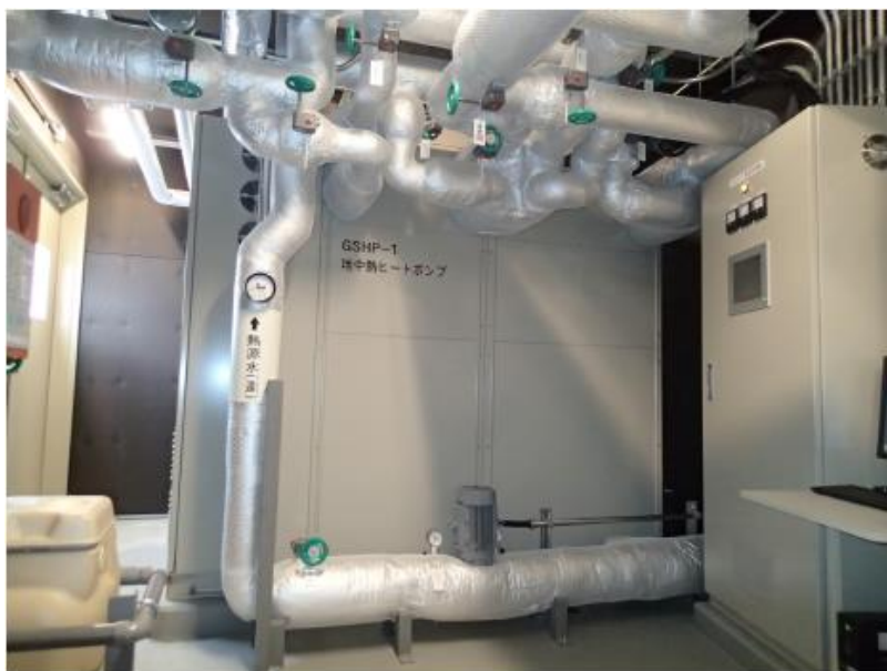
地中熱ヒートポンプ
