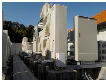
高効率ビルマルチエアコン（室外機）
