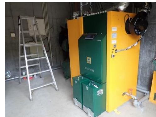
バイオマスボイラー(チップ)
