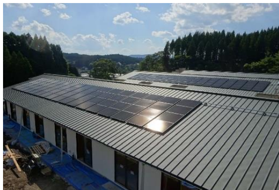
太陽光発電設備
