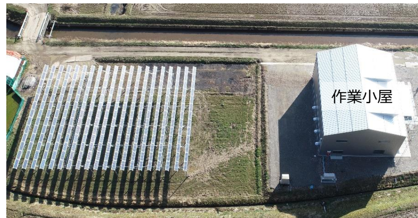
営農型太陽光発電設備の全景
