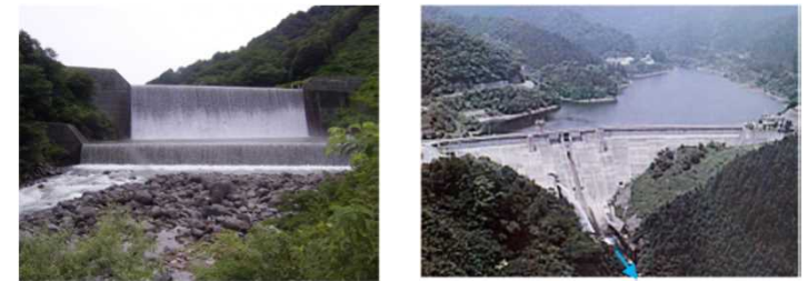
既存砂防堰堤等にはまだ有効利用されていない発電ポテンシャルが存在。
