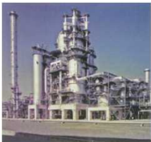
<石油精製所を活用したリサイクル設備>
