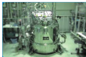
<バイオマスプラスチック製造設備>
