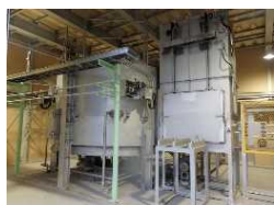
<Li-ion電池リサイクル設備>
