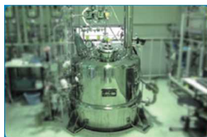
<バイオマスプラスチック製造設備>
