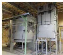
Li-ion電池リサイクル設備
