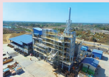
JFEエンジニアリングが建設したミャンマー初の廃棄物発電プラント
