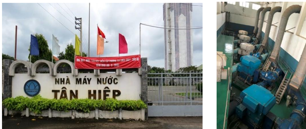
図 3.8 Tan Hiep 1 浄水場、インバータ対象ポンプ
