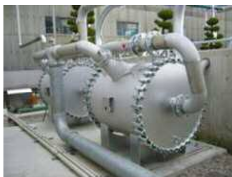
1HK 式熱交換器 (52 m 2 ,1.1m (1HK 型))
