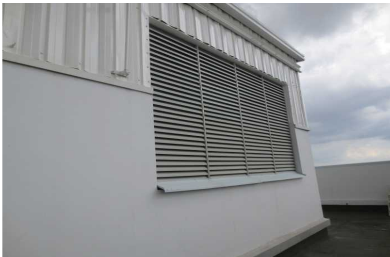
図 屋上外気取入口
