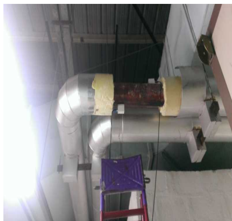
図 屋上階一次冷水配管流量測定
