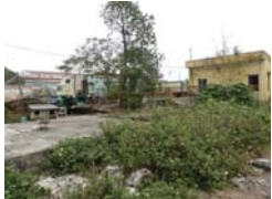
稼働していない処理施設(Vinh Niem工業クラスター)
