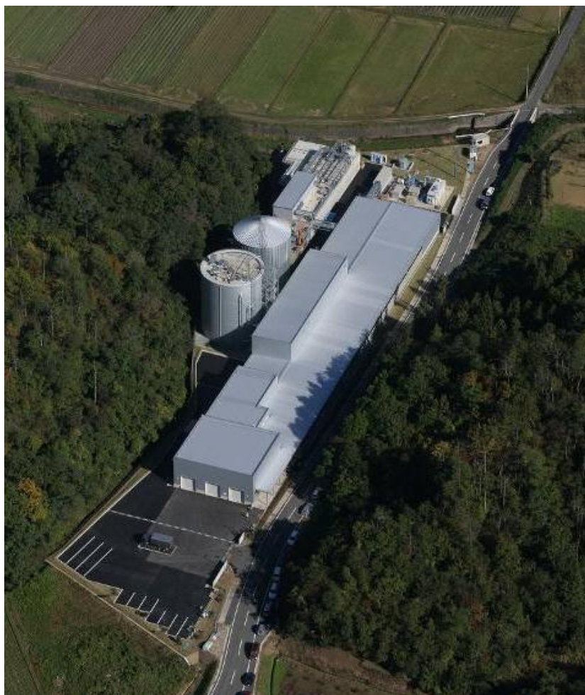
写真 1.2.(1) アミタが運営するバイオガス施設（京都府京丹後市）
