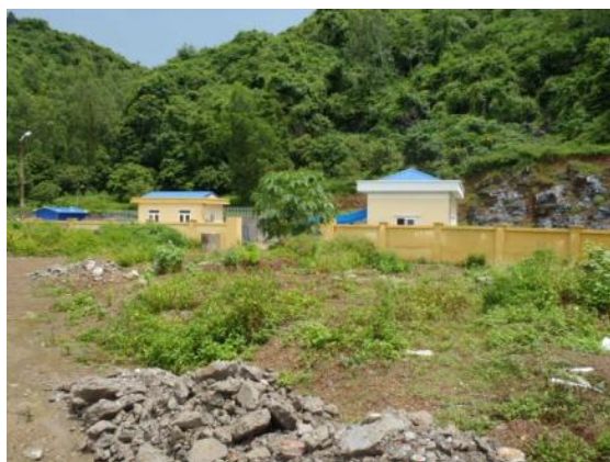
写真 2.1.(11) 建設中の下水処理施設
