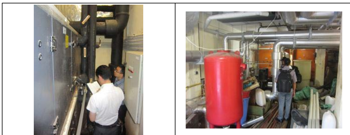
図表 16. 現地調査の様子
