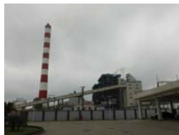
Hai Phong 1 石炭火力発電所
