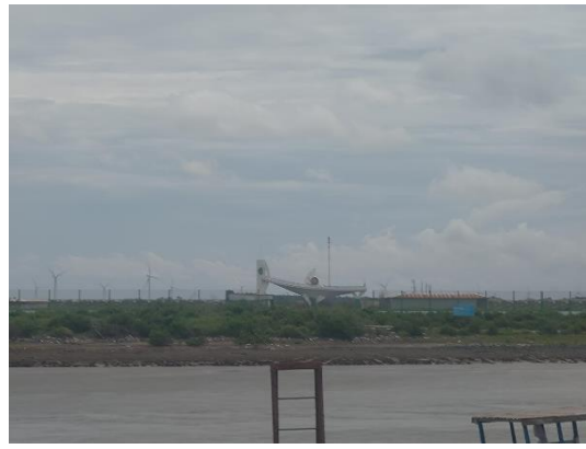
グリーン水素プラント工事の様子
