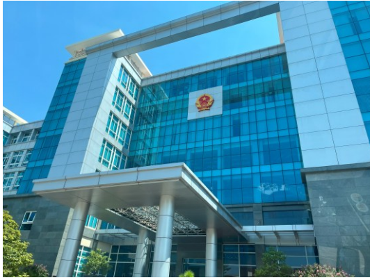
フエ市旧トゥアンホア区庁舎
