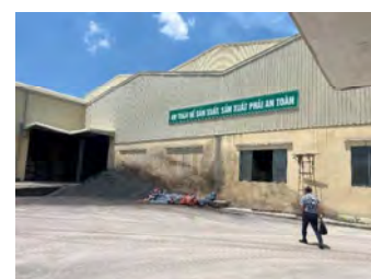
工業団地内の工場の様子
