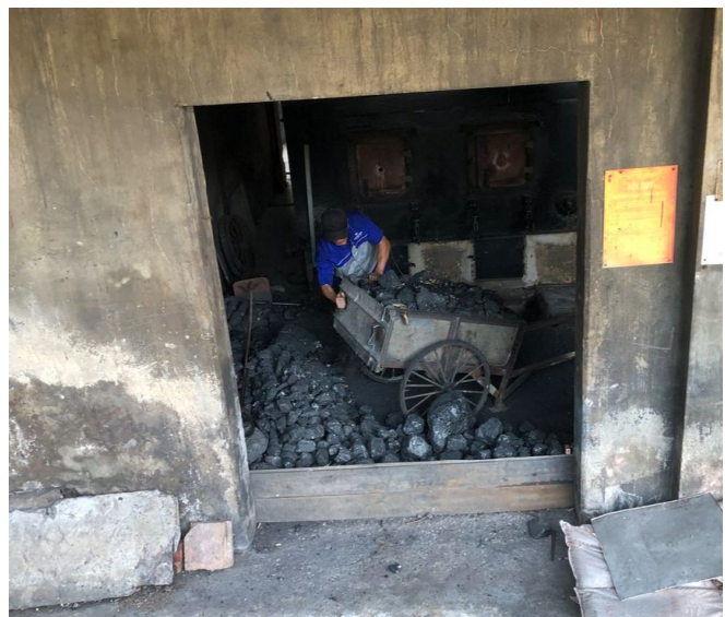
図9 石炭燃料の保管倉庫
