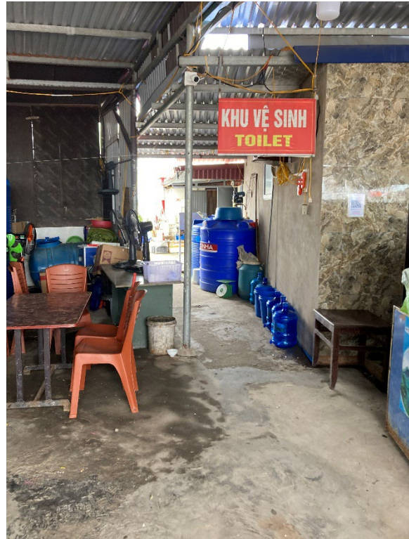
図 24 現在のトイレ（奥側）
