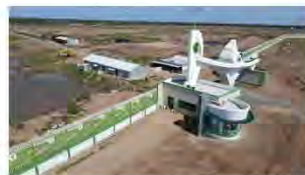
着工したサイトの様子
