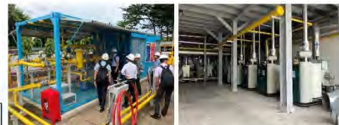
CNG受入設備 (減圧装置) (左) とCNGボイラー (右) 石炭からCNGへの転換により、人件費削減、安全性向上などが認められている。一方で、ランニングコストの上昇も懸念されている。
