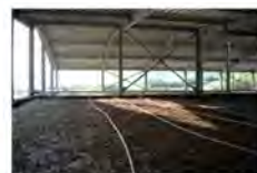
併設されるバイオフィルター ウッドペレットを用いることで 臭気を吸着する。
