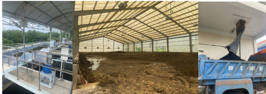
図 4-9 汚泥の脱水の様子
