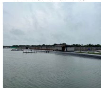
給水池と塩素消毒小屋（中央）
