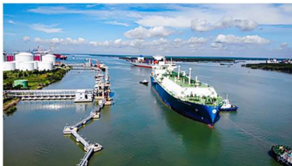
図 2-9 Thi Vai LNG 受入基地外観 6
