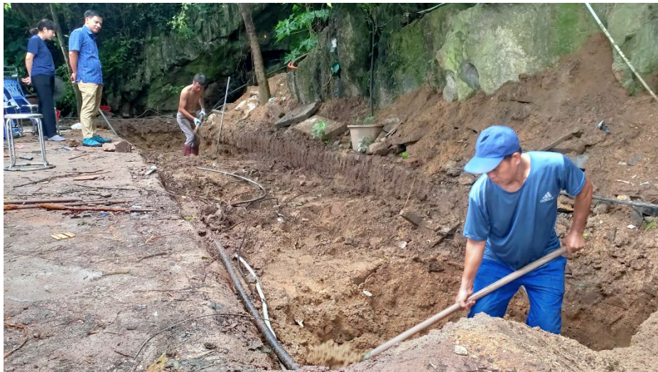
写真 9 工事中の様子(2023 年 8 月 15 日)
