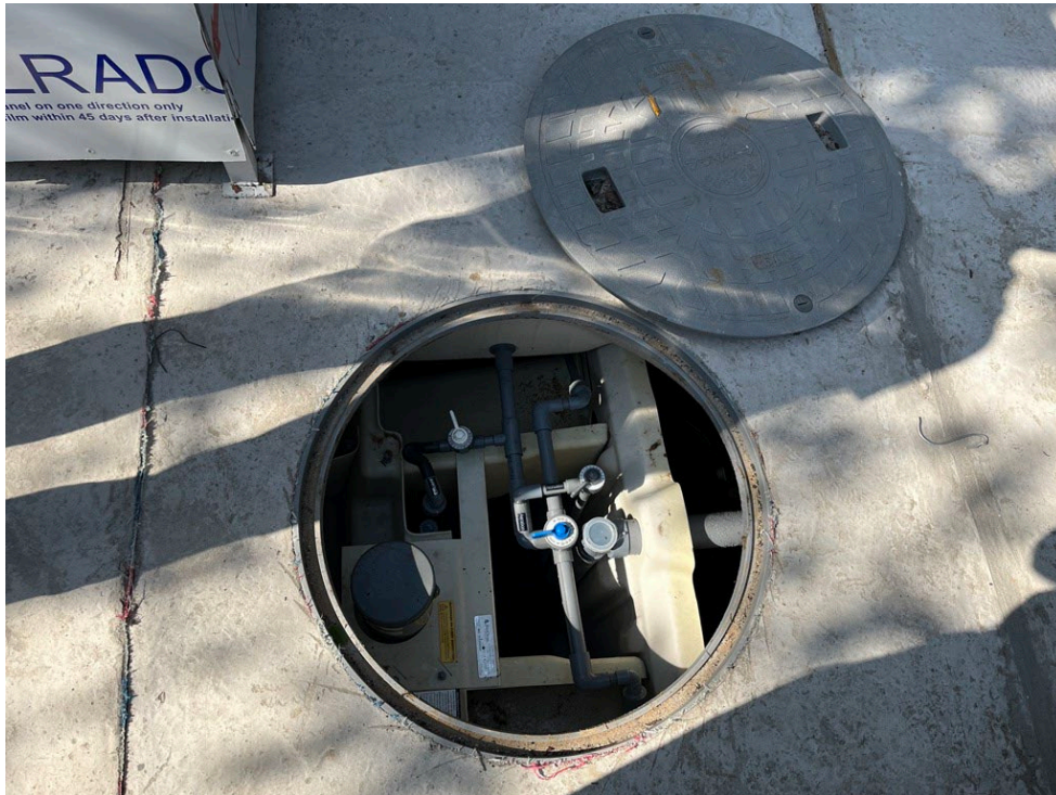
写真 13 ほぼ完成状態の浄化槽(2023 年 11 月 25 日)
