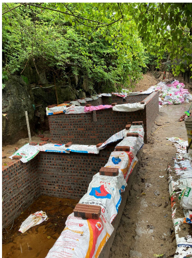
写真 10 工事中の様子(2023 年 9 月 12 日)
