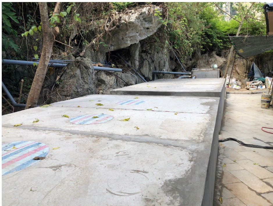
写真 11 工事中の様子(2023 年 11 月 10 日)
