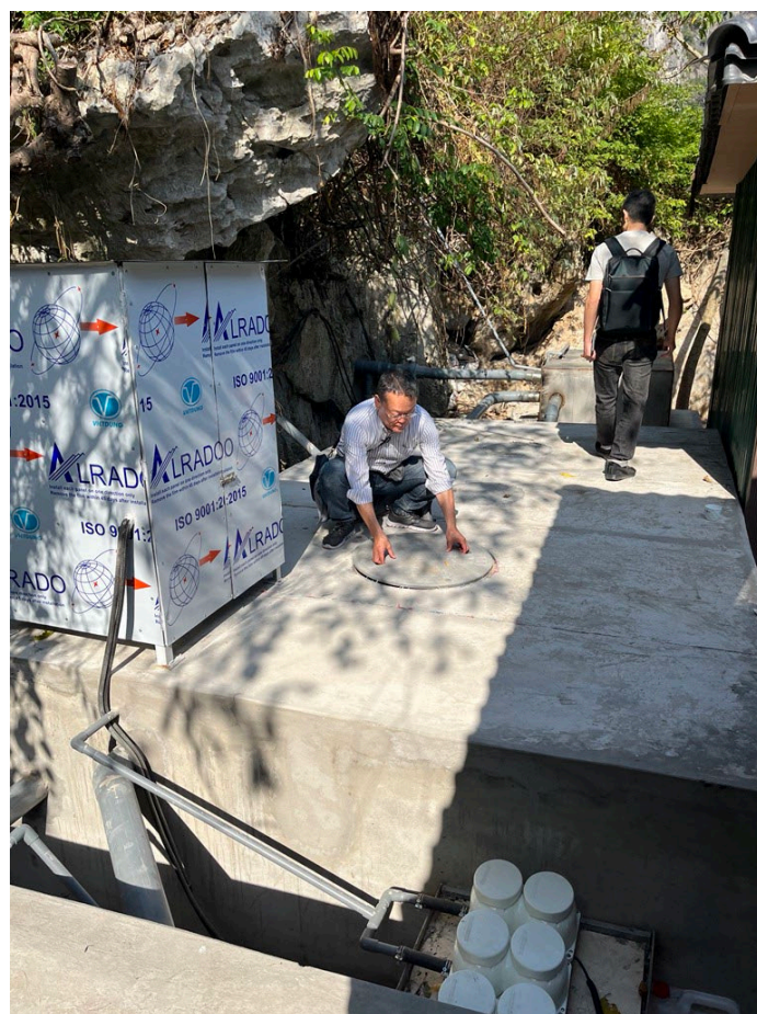
写真 12 ほぼ完成状態の浄化槽(2023 年 11 月 25 日)
