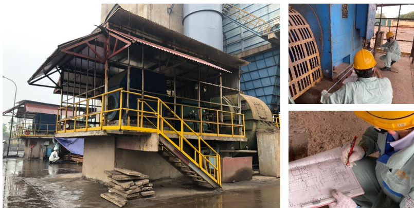
JCM設備補助事業への申請を予定している大型送風機と現地調査の様子
