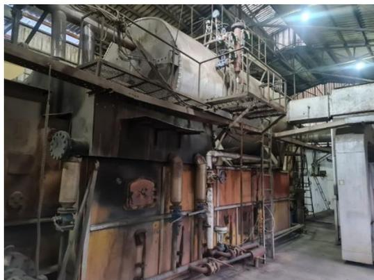
図 76 燃焼室と水管ボイラ部
