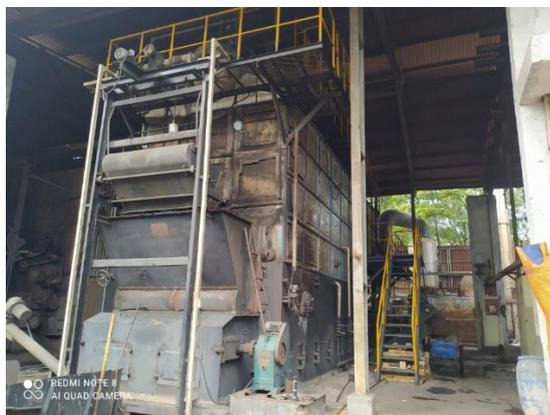
図 66 AGTEX28 のベトナムボイラ製 単胴型自然循環ボイラ（移動床ストーカ焚）
