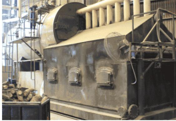
図 71 標準的な石炭ボイラの外観写真
