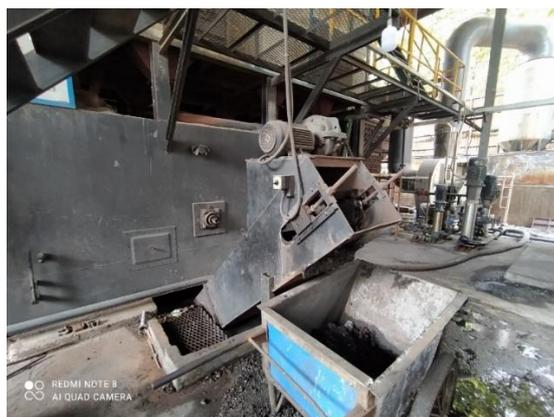
図 70 炉底スラグの排出設備
