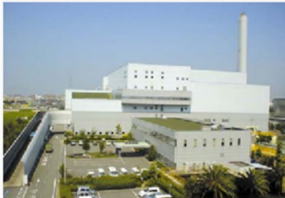
クリーンセンター東工場 (焼却処理・廃棄物発電)
