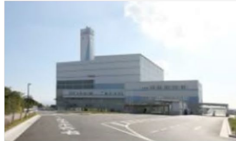
クリーンセンター臨海工場 (溶融処理※・廃棄物発電) ※1,700℃～1,800℃の高温でごみを溶かすことで、 金属分はメタル、それ以外はスラグとしてリサイクル
