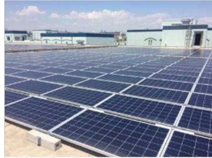
下水処理場への設置
